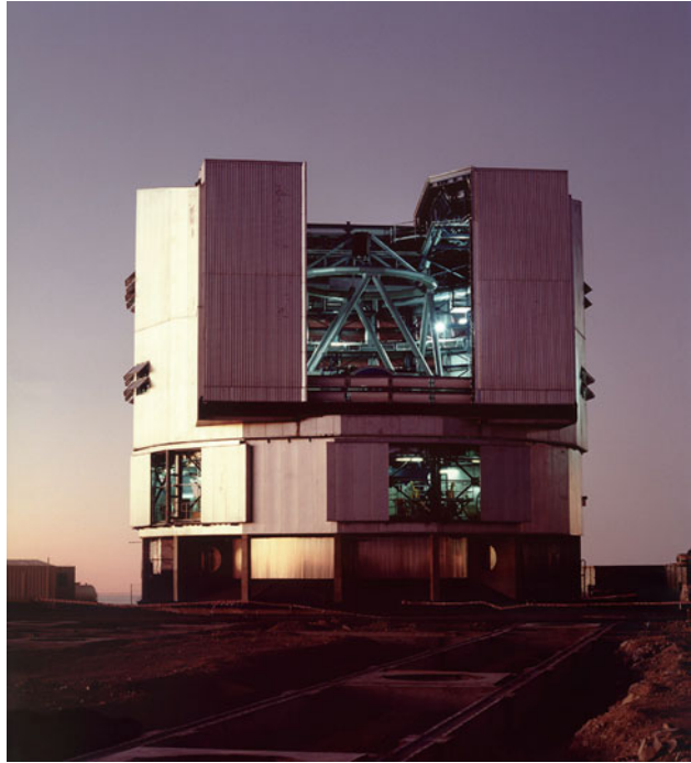
Abb. 5.6 Das Very Large Telescop (VLT) der ESO. Vier 8-m-Teleskope werden zu einem Teleskop über Interferometrie verbunden (© ESO)
